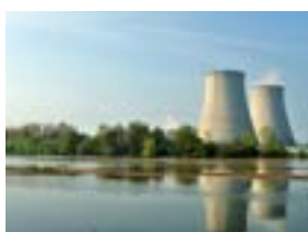
Réseaux de surveillance des sites nucléaires
